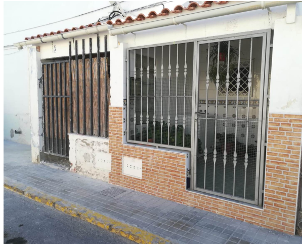
Imagen 1. Vista fachada Calle Marqués de Valterra, 3
