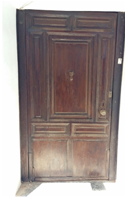
Imagen 1. Puerta a planta baja de C/ Hort. Exterior.
