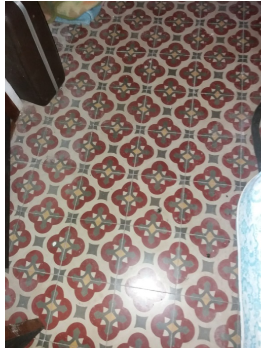
Imagen 6. Pavimento hidráulico.
