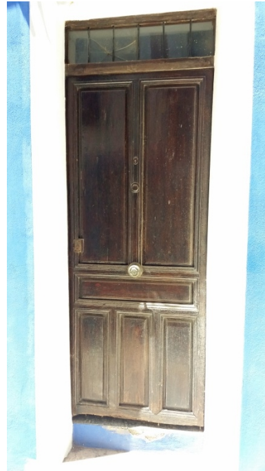
Imagen 4. Puerta a escalera de acceso a plantas altas de C/ Hort. Exterior.
