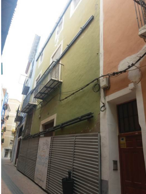
Imatge 1. Façana a C/ *Major, 3.
