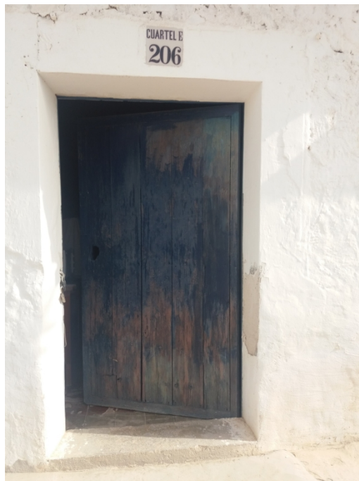
Imagen 1. Azulejo a conservar in situ sobre la puerta principal.
