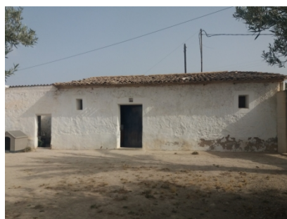
Imagen 2. Fachada principal del inmueble
