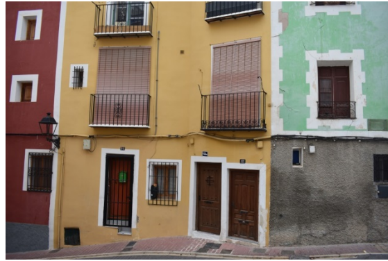
Imagen 3: fachada a C/ S. José. Véase el pescante metálico en el balcón derecho.
