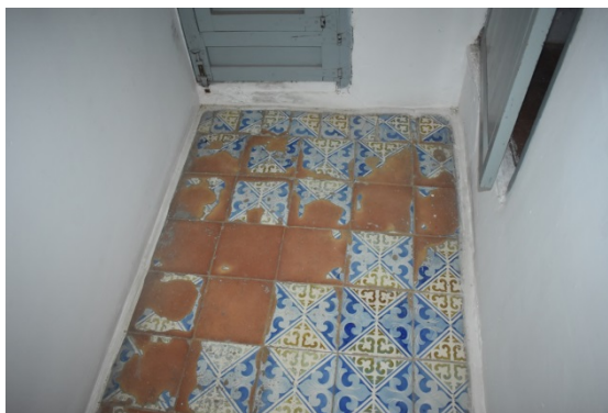
Imagen 2: pavimento de azulejos del s. XIX.
