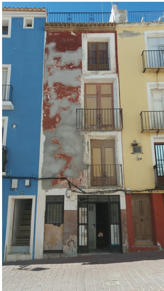
Figura 3. Estado actual de fachada a calle Costereta, 28.
