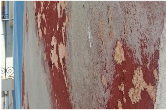
Figura 5. Es veu clarament que el color roig de la façana és una pintura elàstica espessa que es desprén amb facilitat, i no morter antic a la calç.
