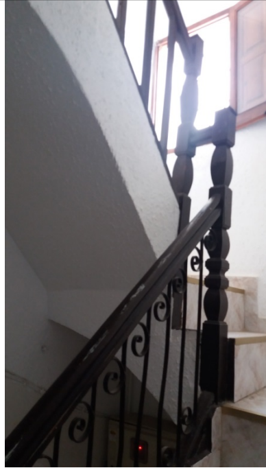
Figura 2. Barana d'escala interior.
