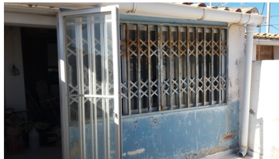
Figura 6. Rejas, puerta y canalón impropios en cuerpo de terraza.
