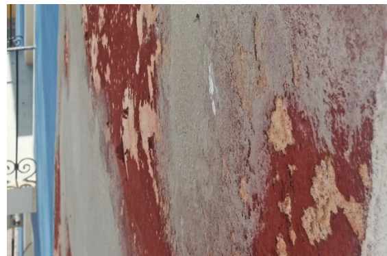
Figura 5. Se ve claramente que el color rojo de la fachada es una pintura elástica espesa que se desprende con facilidad, y no mortero antiguo a la cal.
