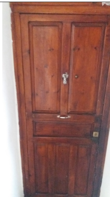
Figura 4. Puerta de acceso a vivienda en planta 3ª.
