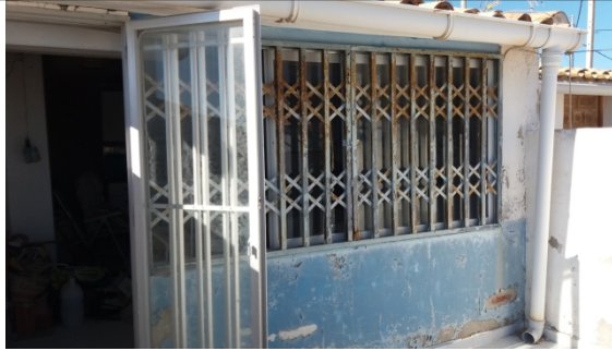
Figura 6. Reixes, porta i canaló impropis en cos de terrassa.
