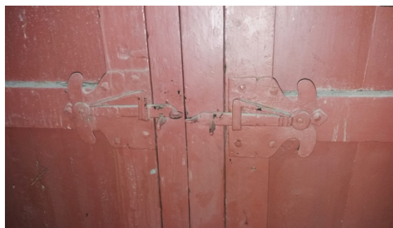
Figura 2. detalle de herrajes de puerta balconera de planta 2.
