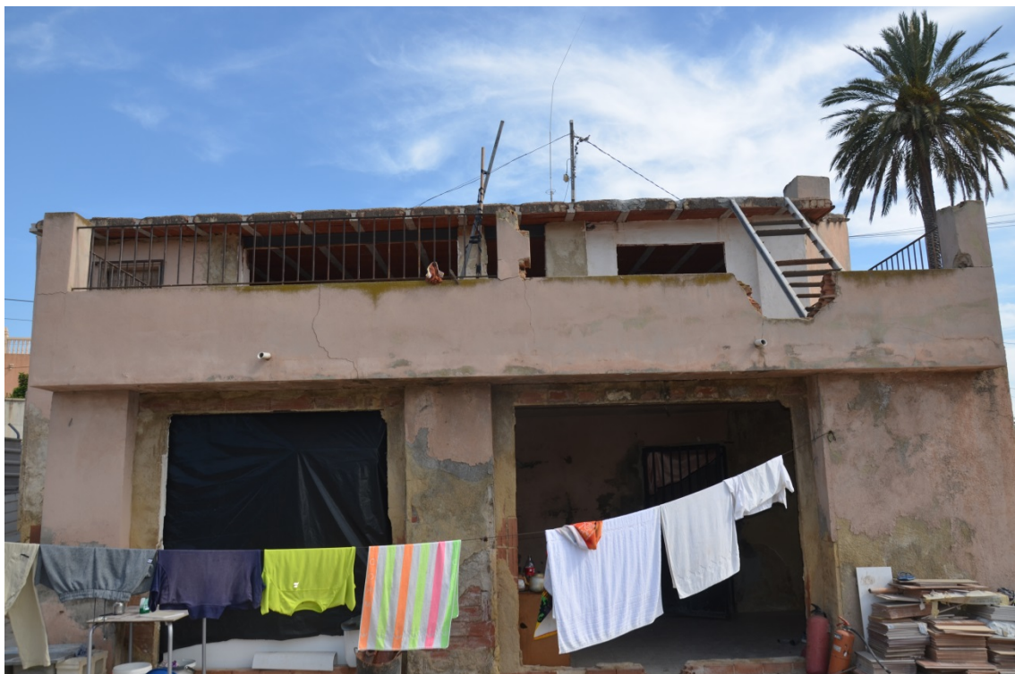
Imagen 1. Vista de la fachada principal del inmueble.
