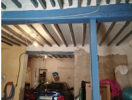
Figura 1. Pilar i cairats. Estat actual.
