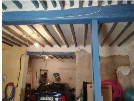
Figura 1. Pilar y viguetas. Estado actual.
