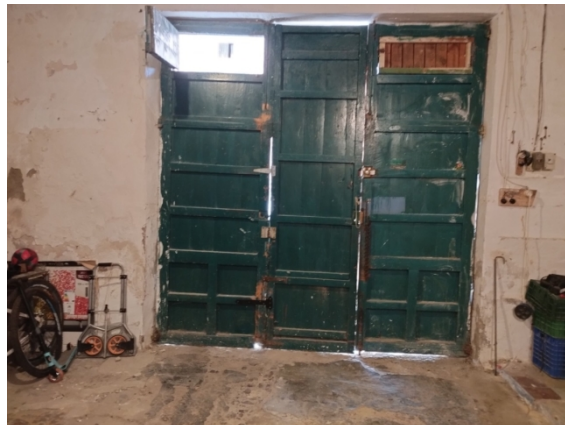
Figura 2. Portón antiguo de acceso, con valor patrimonial. Vista interior.
