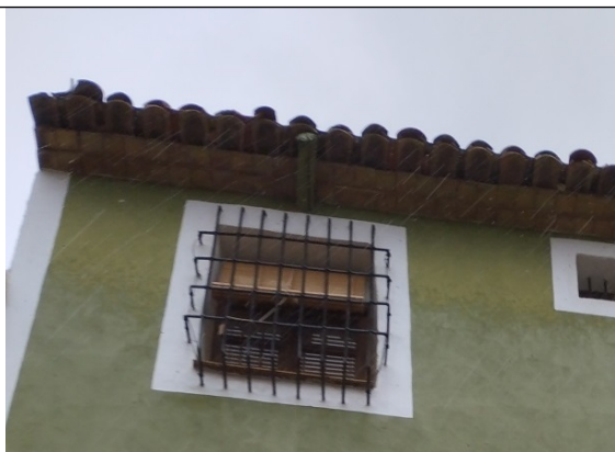
Imatge 5. En el centre de la imatge, sobre la finestra, mènsula muntacàrregues de fusta.
