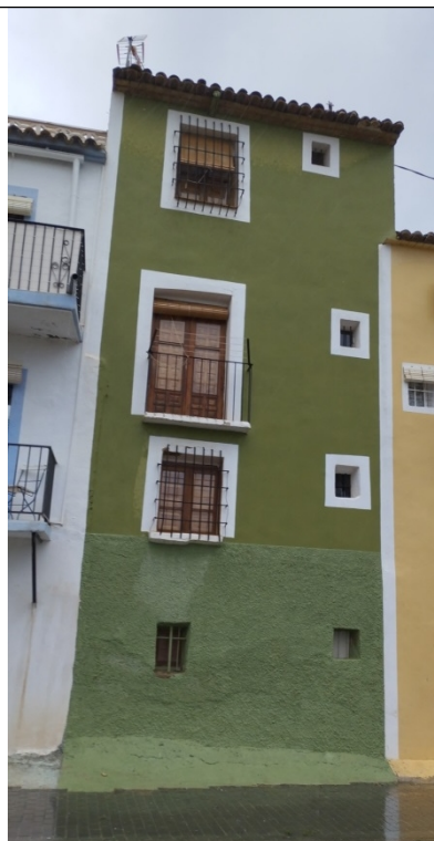
Imagen 11. Fachada al río.
