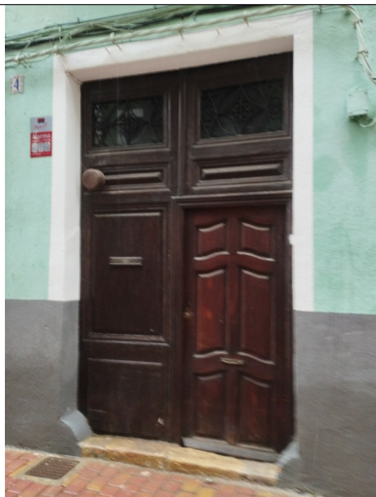
Imatge 3. Porta d'accés a l'immoble per carrer San Telmo.
