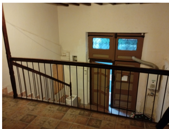
Imagen 8. Barandillas del altillo del primer piso y la escalera en la entrada a la vivienda.
