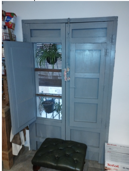
Imagen 4. Interior de puerta balconera en C/ Álvaro Esquerdo.
