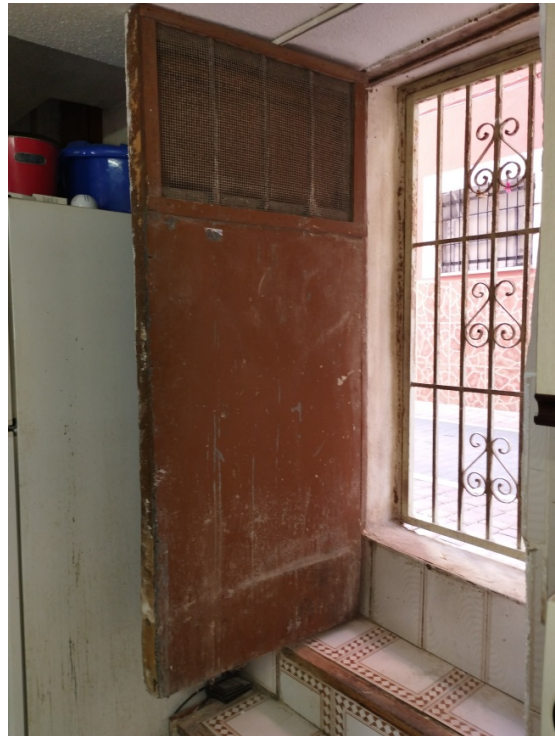
Figura 8. Puerta antigua en C/ Sant Pere, a conservar. Vista exterior y reja a eliminar.
