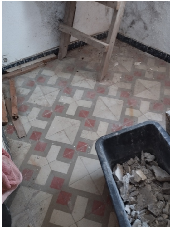
Imagen 11. Pavimento de baldosas hidráulicas en interior.
