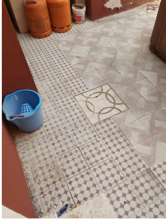
Imagen 10. Pavimento de baldosas hidráulicas del patio.
