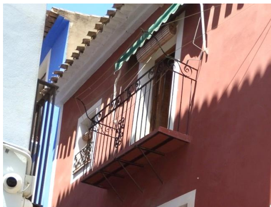
Imagen 9. Pescantes antiguos en balcón de 2ª planta en C/ Soletat.
