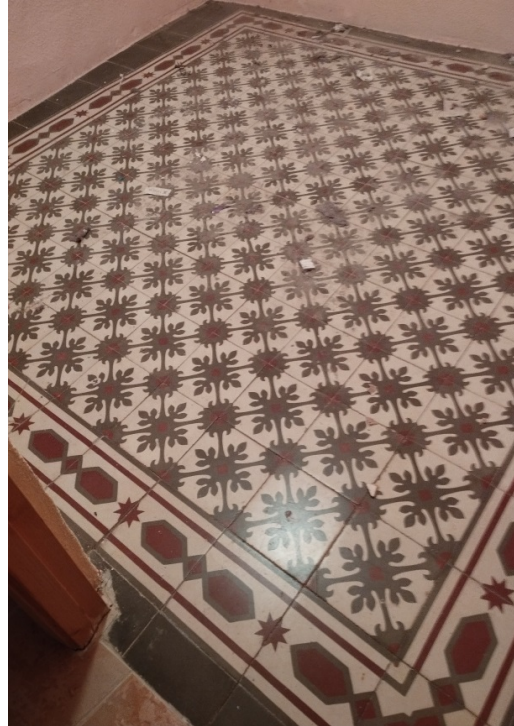
Imagen 12. Otro pavimento de baldosas hidráulicas en interior.
