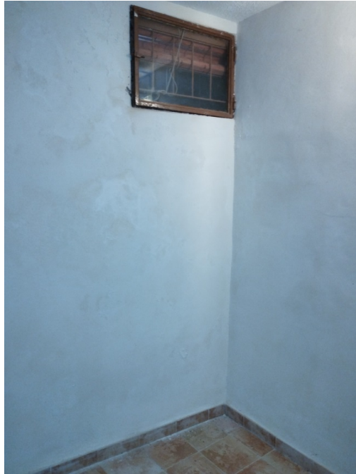
Imagen 7. Ventana a sustituir.
