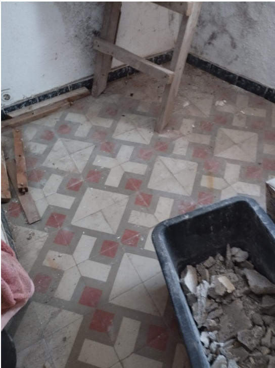
Imatge 11. Paviment de rajoles hidràuliques en interior.
