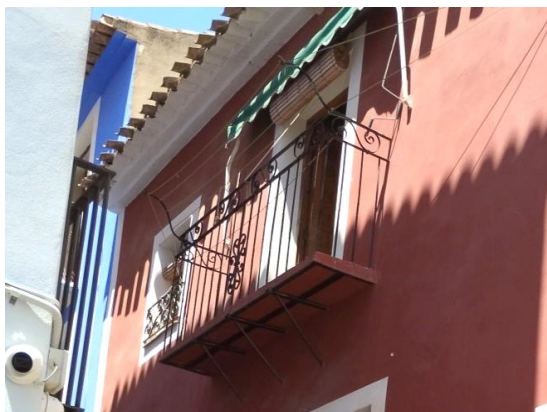
Imatge 9. Pescants antics en balcó de 2a planta en C/ Soletat.
