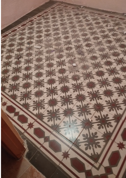
Imatge 12. Un altre paviment de rajoles hidràuliques en interior.
