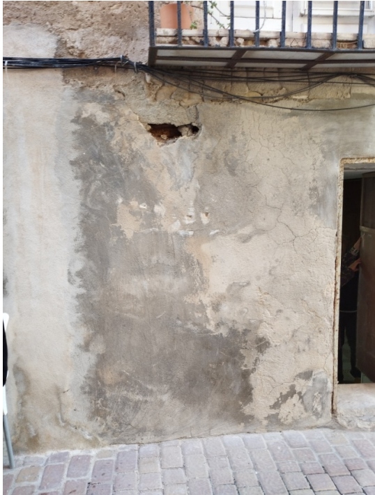
Fig. 4. Tast en façana a carrer Sant Pere amb restes de grassó carregador de buit antic de finestra, a recuperar.
