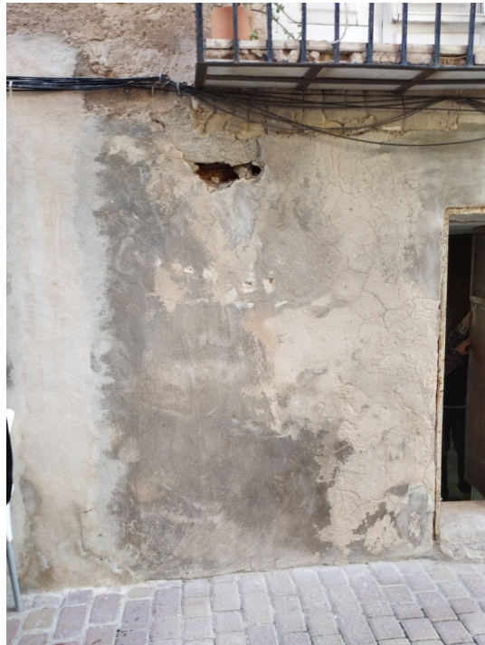
Fig. 4. Cata en fachada a calle Sant Pere con restos de rollizo cargadero de hueco antiguo de ventana, a recuperar.
