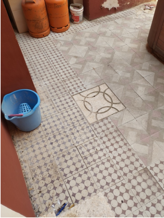
Imatge 10. Paviment de rajoles hidràuliques del pati.
