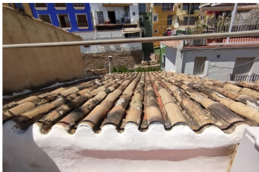
Fig. 3. Estado actual del tejado. Véanse tejas envejecidas artificialmente, a sustituir, usadas en la primera serie de tejas cobijas, la más pròxima al punto de vista.
