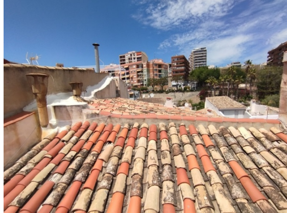
Fig. 2. Vista parcial de los tejados a intervenir.
