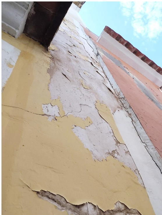
Fig. 4. Parament de la façana a carrer de l'Àngel. Vegeu la pintura moderna sobre l'esquerdejat antic de morter a la calç.
