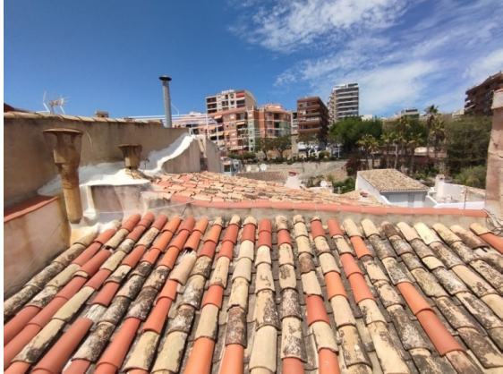
Fig. 2. Vista parcial de les teulades a intervindre.
