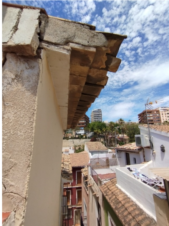
Fig. 3. Vista del alero que se propone recrecer con una hilada más de ladrillos matabancos.
