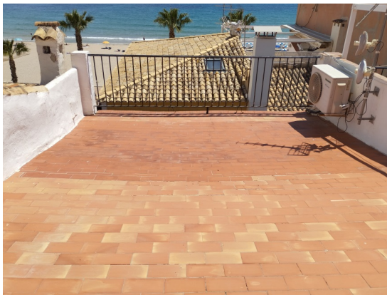
Fig. 7. Barana metàl·lica de terrassa.
