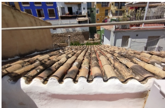
Fig. 3. Estat actual de la teulada. Vegense teules envellides artificialment, a substituir, usades en la primera sèrie de teules aculls, la més pròxima al punt de vista.
