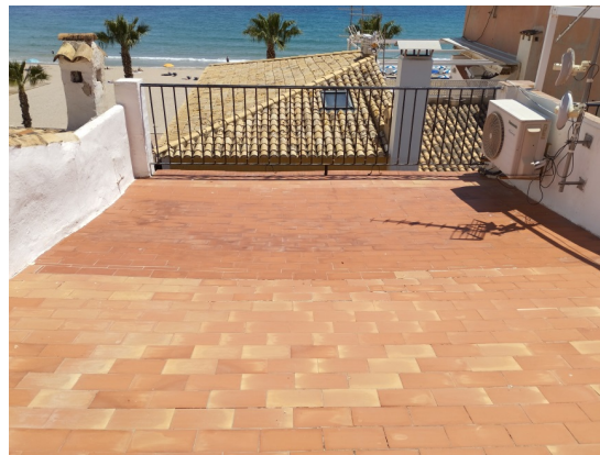
Fig. 7. Barandilla metálica de terraza.
