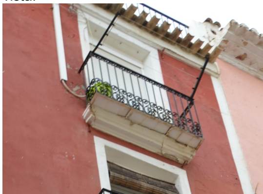
Fig. 3. Estado actual del tejado. Véanse tejas envejecidas artificialmente, a sustituir, usadas en la primera serie de tejas cobijas, la más pròxima al punto de vista.
