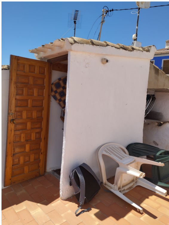
Fig. 2. Cassetó d'accés a la terrassa.
