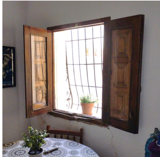
Fig. 6. Ventana a sustituir.
