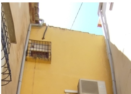
Fig. 5. Clivella en part superior de façana de carreró del Pal, i vista exterior de la finestra a substituir.
