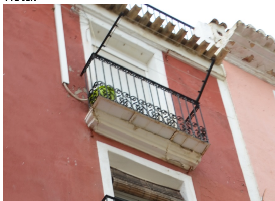
Fig. 3. Estat actual de la teulada. Vegense teules envellides artificialment, a substituir, usades en la primera sèrie de teules aculls, la més pròxima al punt de vista.
