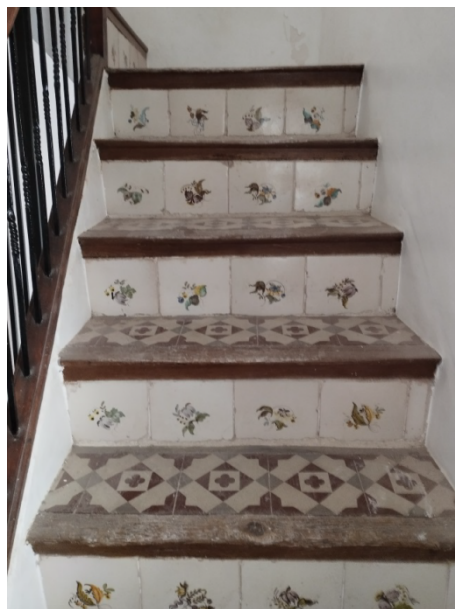
Fig. 4. Elementos de interés patrimonial a conservar en tramo de escalera.
