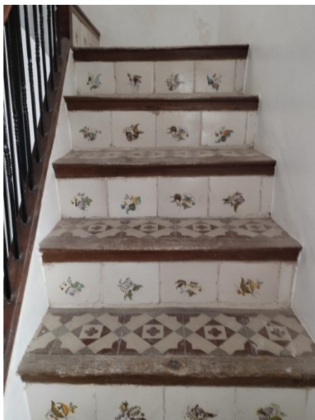
Fig. 4. Elements d'interés patrimonial a conservar en tram d'escala.
