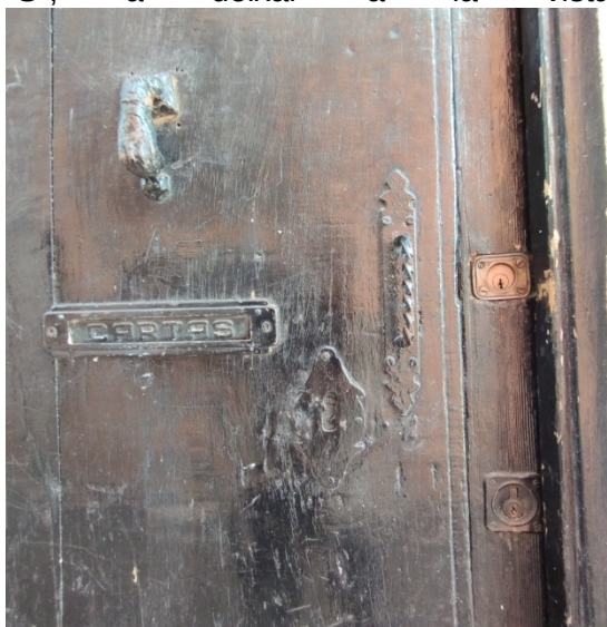
Imatge 9. Detall de decoració de forja en "S", a deixar a la vista.
