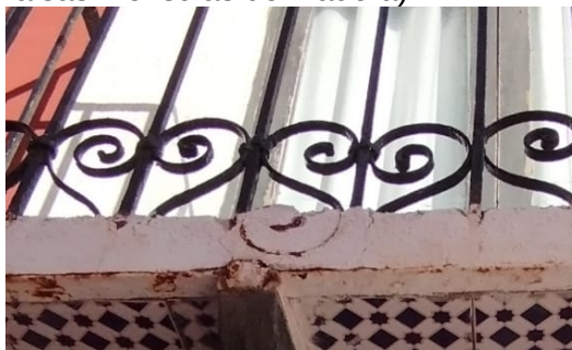
Imagen 8. Vuelo de balcón (detalle de las falsas ménsulas de madera).
