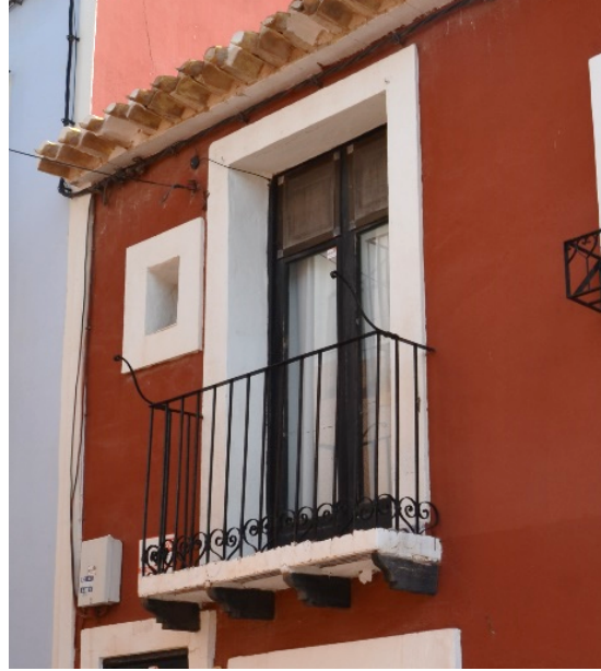
Imagen 4. Puerta balconera de primer piso de fachada a C/ San Telmo.
