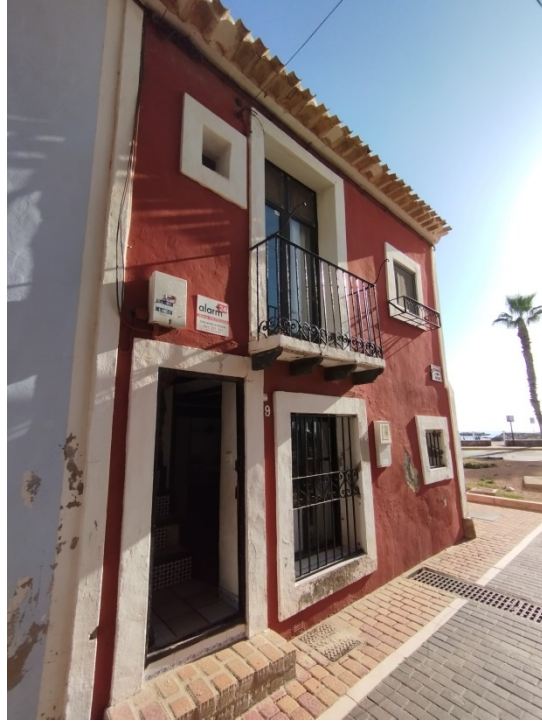
Imagen 2. Fachada a C/ San Telmo
